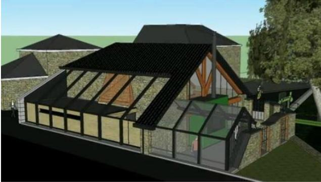
Les anciens éléments de l'édifice tels que la charpente et les murs en moellons de pierre ont été au maximum conservés. Les éléments disparus ou dont la consolidation n'était pas possible ont été remplacés par des matériaux modernes tels que le verre et le métal.
